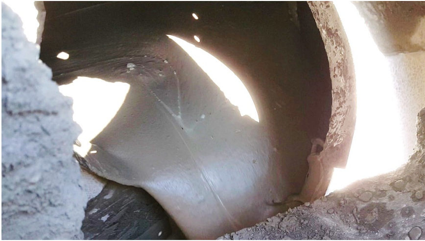
Carga de espuma completada y material homogéneo
