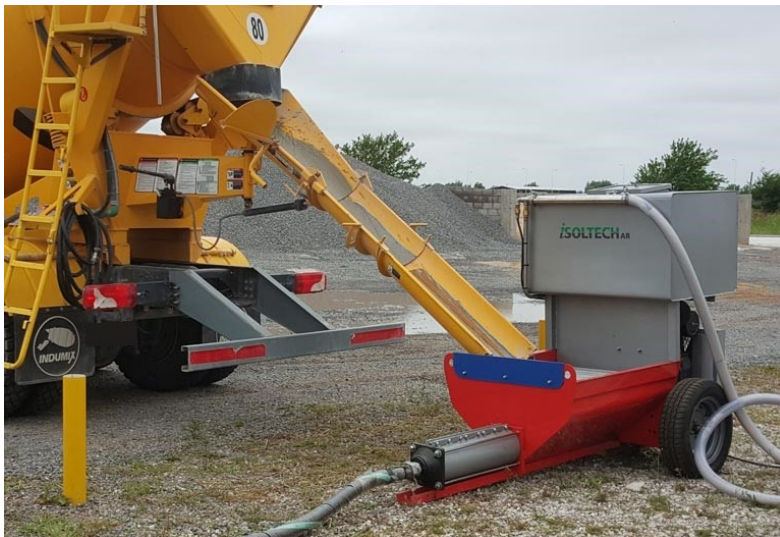
Camion mixer volcando el material en la tolva de bombeo
